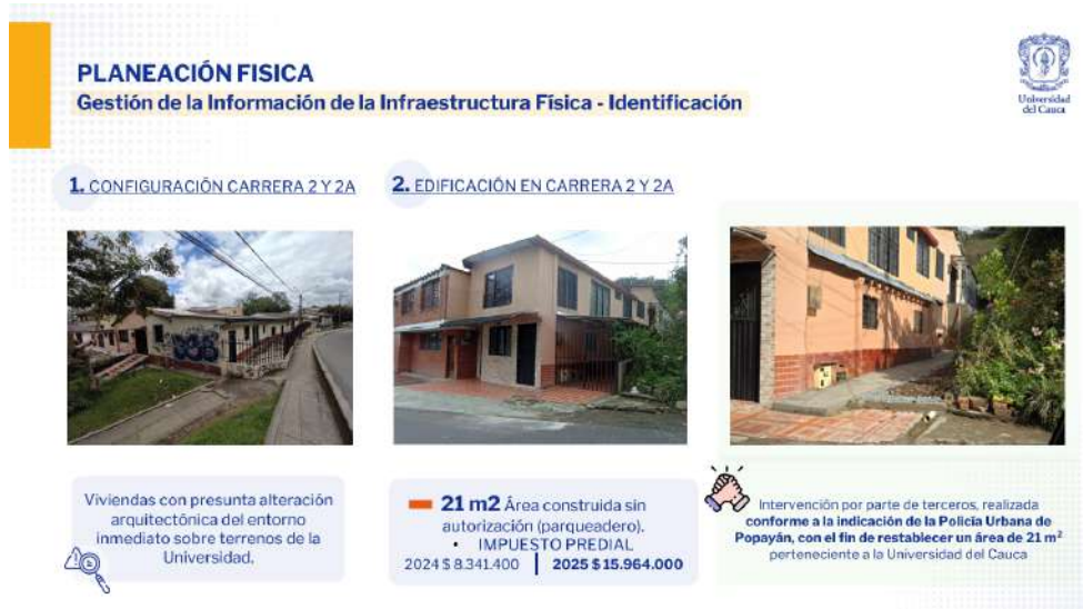
Figura 7. Inconsistencias identificadas en predios de la institución.
